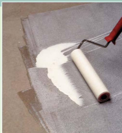
ПАРОПРОНИЦАЕМАЯ ЗАЩИТНАЯ ПРОПИТКА БЕТОННЫХ ПОЛОВ И ПОЛОВ ULTRATOR, НА ОСНОВЕ ВОДНОЙ ДИСПЕРСИИ ЭПОКСИДНОЙ СМОЛЫ.
