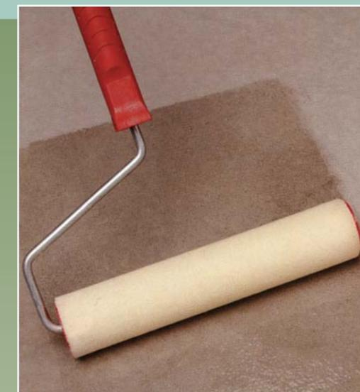
ПРОЗРАЧНОЕ, ПАРОПРОНИЦАЕМОЕ ПОЛИУРЕТАНОВОЕ ПОКРЫТИЕ, БЕЗ РАСТВОРИТЕЛЕЙ, С ВЫСОКОЙ ИЗНОСОСТОЙКОСТЬЮ, ДЛЯ ПРОПИТКИ ПОЛОВ ВНУТРИ И СНАРУЖИ ПОМЕЩЕНИЙ И ДЛЯ ЗАЩИТНОЙ ПРОПИТКИ ПОЛОВ ULTRATOR.
